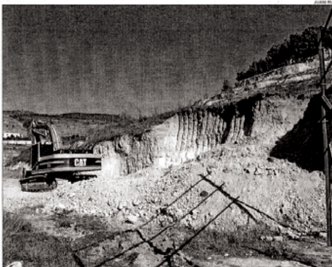
Obras paralizadas de 67 viviendas al pie del cerro de Santa Lucía, cuya cima está declarada como BIC desde 2003
