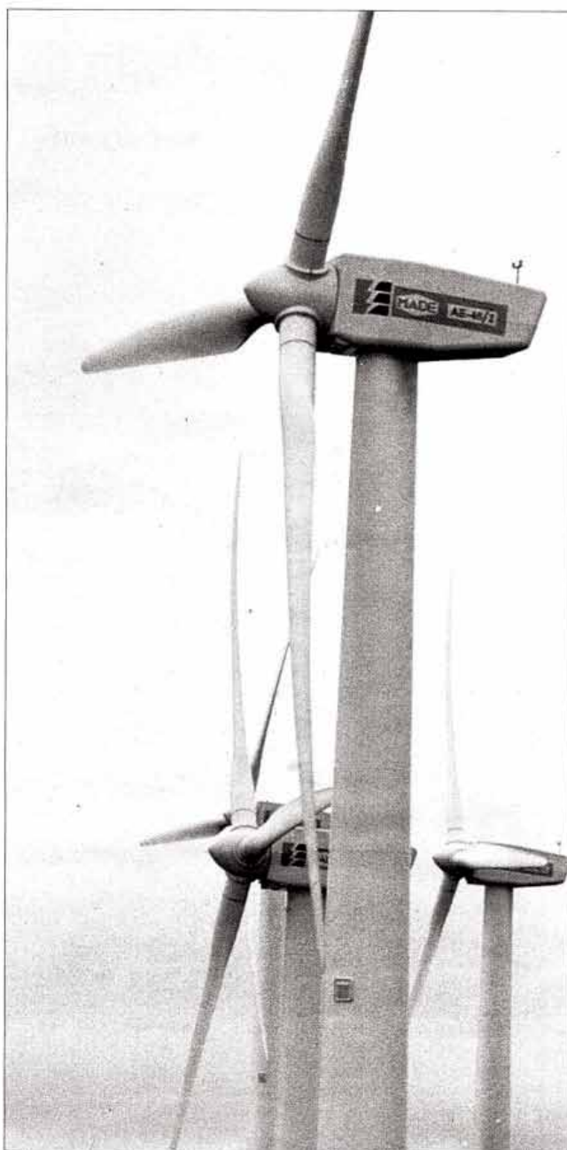
Varios aerogeneradores instalados en la zona de Ólvega. / FERNANDO SANTIAGO
