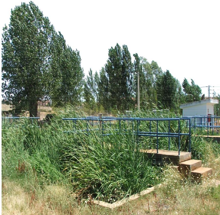
En este tipo de aplicaciones las macrofitas suplen de forma natural la labor de aireación y oxigenación del lecho depurador, que se realiza habitualmente por medio de equipos electromecánicos de alto consumo energético. Por ello es una eficaz y sencilla opción para la rehabilitación de Depuradoras que han perdido su capacidad de tratamiento o que están en desuso por sus altos costes de explotación.
